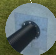
Prechod stenou - tlaková voda
