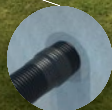
Prechod stenou - netlaková voda
